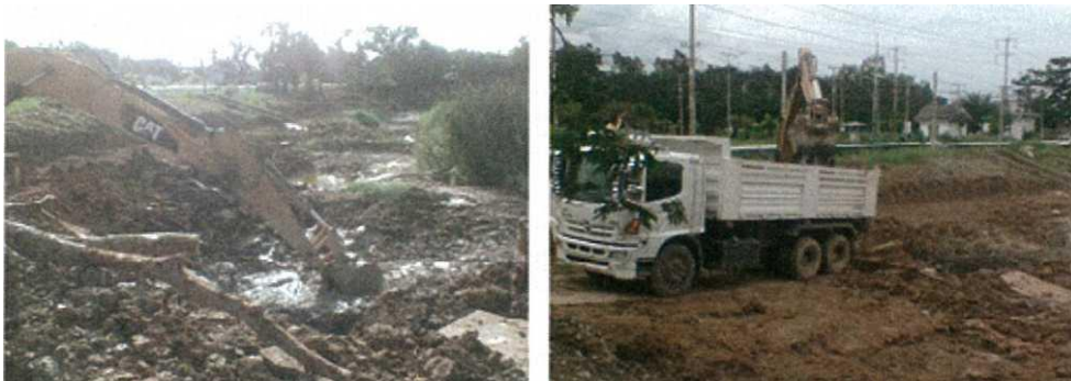
ภาพที่ 1-1 การขุดลอกบ่อบริเวณบึงชะลอน้ำส่วนหน้า (Pond A)
